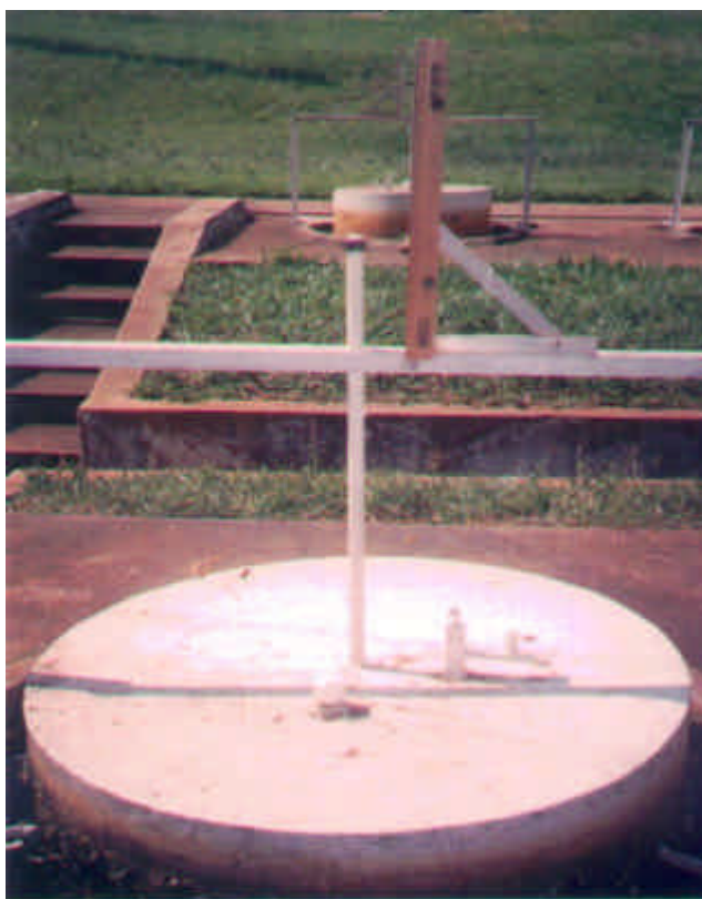
Figura 4 – Vista do gasômetro do biodigestor da área experimental do Departamento de Engenharia Rural da Faculdade de Ciências Agrárias e Veterinárias – Campus de Jaboticabal, da Universidade Estadual Paulista -UNESP.
