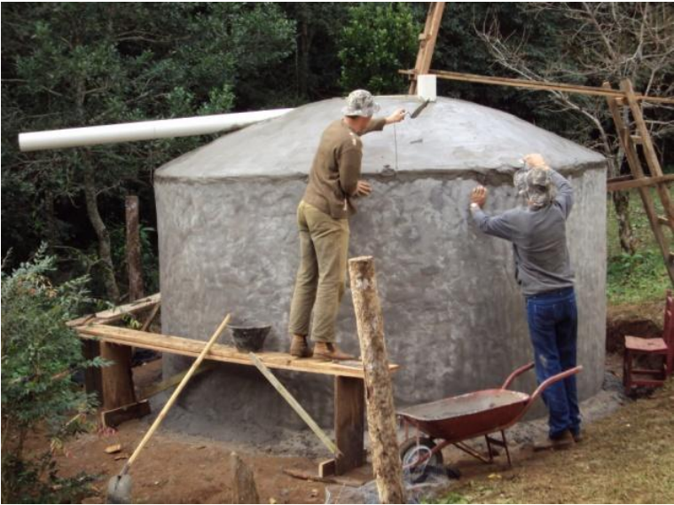
Foto 78 - Construção de cisterna ferro-cimento para o armazenamento de água da chuva: desenvolvido em âmbito dos projetos do servidor da UNIOESTE, campus Francisco Beltrão, Luciano Z. P. Candiottto. Fonte: Luiz Schimitz, 2012 (Família “F”, 2012).
