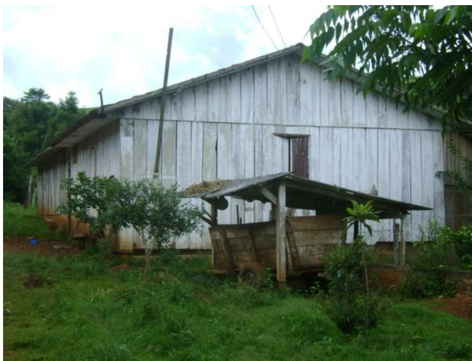
Foto 62 – Vista externa do paiol e da estrebaria. À frente da fotografia destaque para a gaiota alocada na estrutura coberta. 2011.
