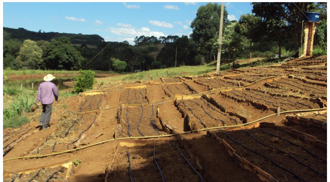
Foto 87 - Construção de canteiros irrigados por técnica de gotejamento construído no desenvolvimento dos projetos do servidor da UNIOESTE, campus Francisco Beltrão, Luciano Z. P. Candiottto. Fonte: Luiz Schimitz, 2012 (Família K, 2012).
