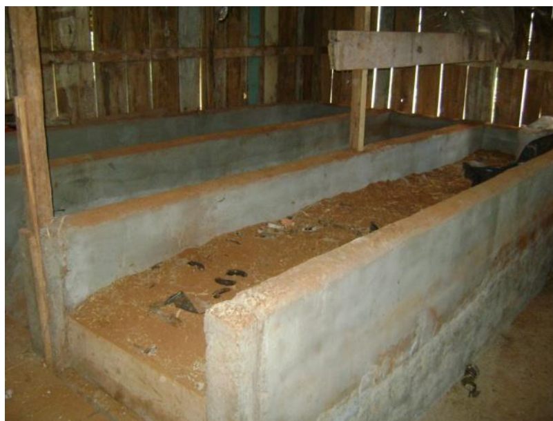
Foto 63 – Vista parcial do sistema de silagem para grão úmido construído dentro do paiol, 2011.
