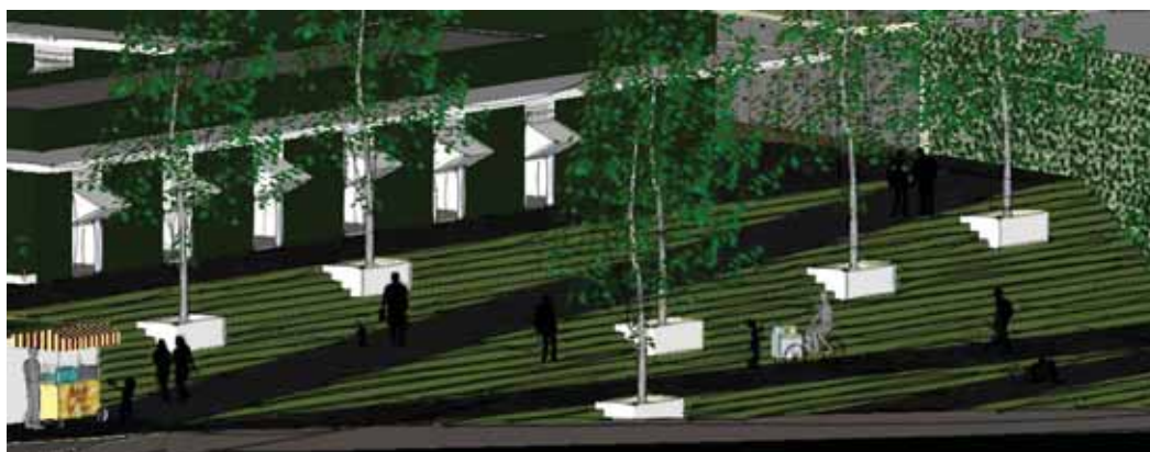
Figura 92 - Escada rampa que liga o Terminal ao interior do Mercado, vista da Rua Casemiro Dias. Fonte: Autora, 2011.
