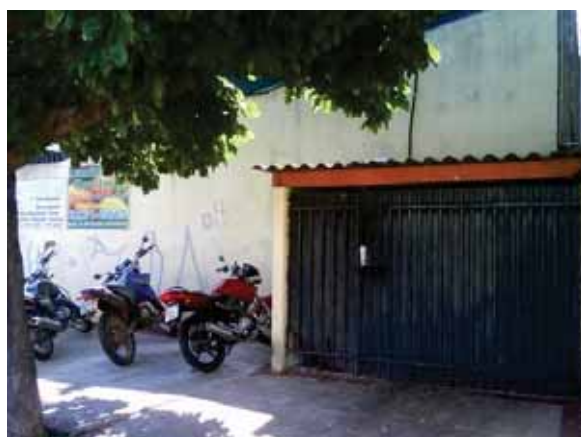
Figura 3,4 e 5 - Entrada do Mercado Modelo pela Rua Djalma Dutra e pela Rua José Dias Cintra, respectivamente e a seguir, o depósito de lixo. (Fonte: Autor, 2010).
