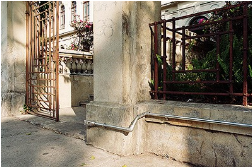
Figura 14: Detalhe da extensão da tubulação elétrica de “Calçada” de Rubens Mano. Autoria: Rubens Mano, 1999. Foto: fonte desconhecida.
