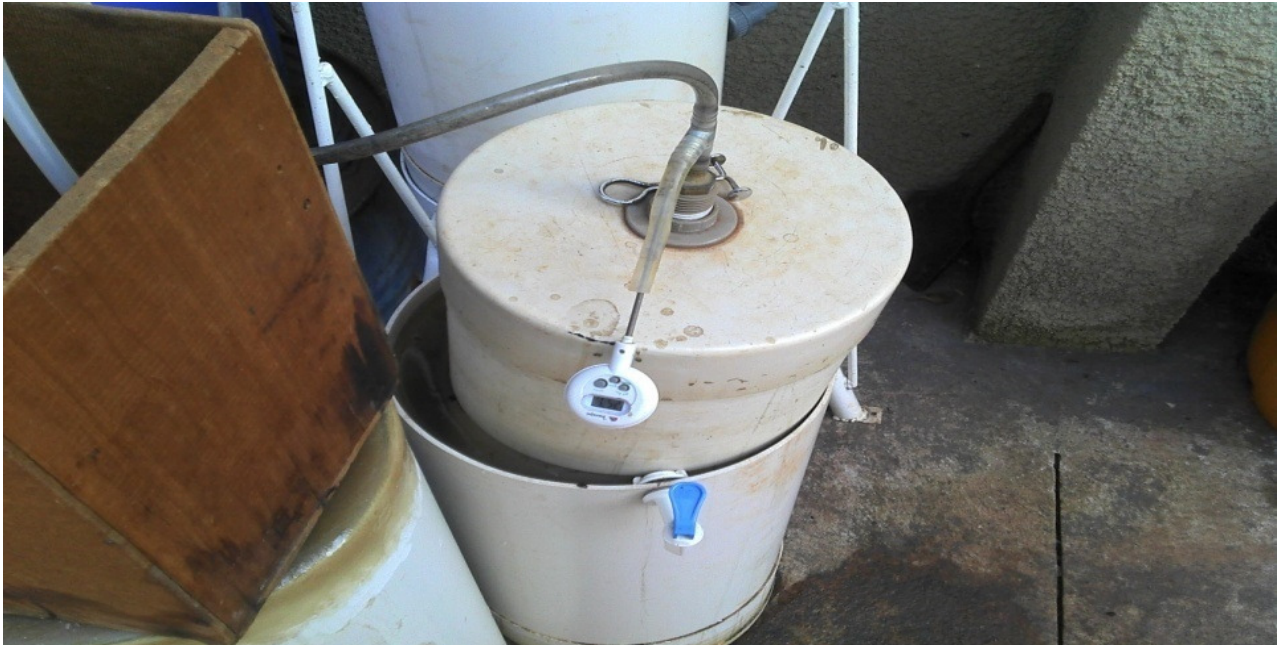
Figura 6. Vista de gasômetro utilizado no sistema. Fonte: o autor
