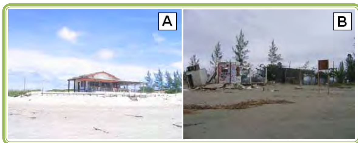
Figura 34. Alguns impactos decorrentes da ocupação desordenada. A – Quiosque sobre dunas em Ilha Comprida; B – Ruínas e casa construídas na região de pós-praia, em Ilha Comprida. (fotos: Ágata Romero)
