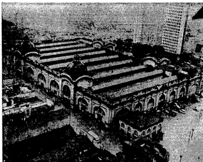
Figura 5 – Outra imagem do prédio do Mercado Municipal sendo invadido pelas águas
