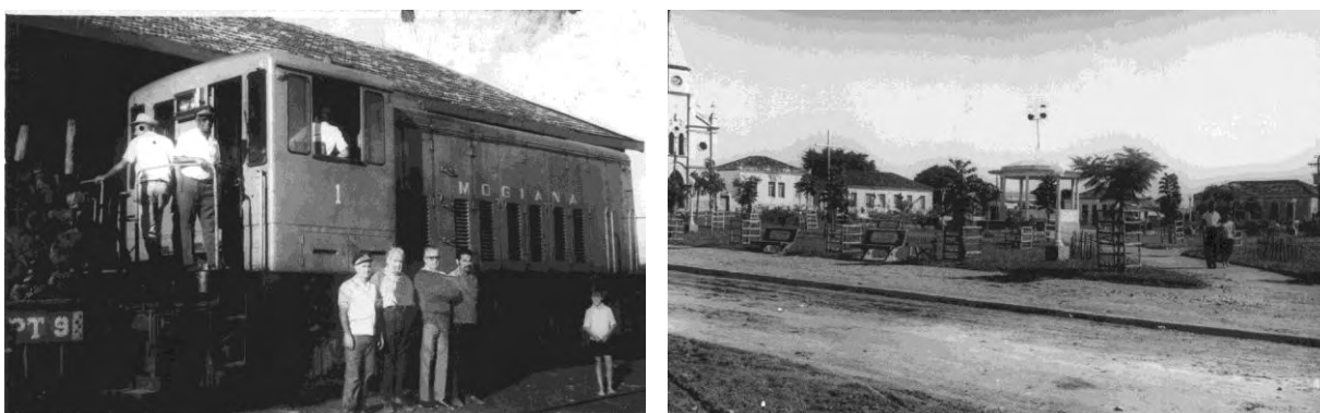
Figura 16 - Estação de Cristais Paulista, 1971 - Locomotiva GE Cooper-Bessemer de 660 HP tipo C+C, adquirida em 1952. Foto de Marcio Fernando Dib e Praça Nossa Senhora d'Abadia, 1962. (Fonte: AH de CP).
