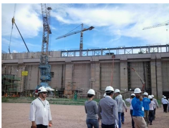
Figura 11. Parte da barragem em construção.
