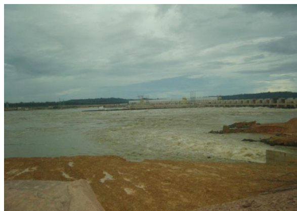
Figura 10. Vista das casas de turbinas.
