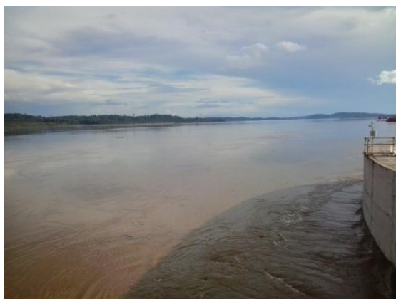
Figura 9. Parte montante da barragem .
