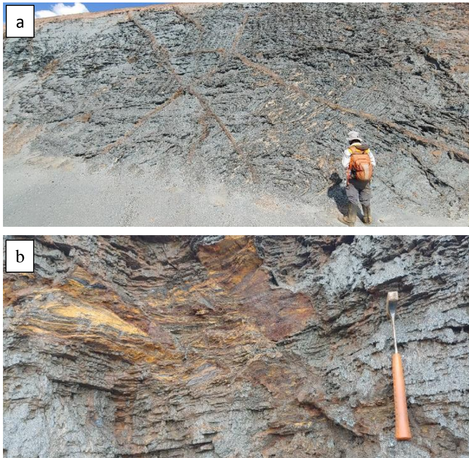
Figura 48. Itabirito friável com resistência muito branda inferior (R1-) (a) e grau de alteração de rocha completamente alterada (W5) (b).
