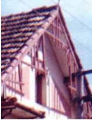
Figura 80: Detalhe da edificação antiga Fonte: Museu e arquivo histórico municipal
