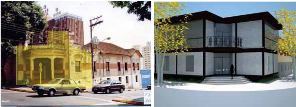
Figura 79: Montagem – Destaque da porção do edifício destruída em 1990 e imagem 3D Fonte: autora, 2011
