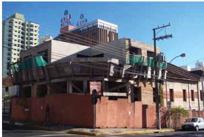
Figura 6: A construção sobre o antigo Hotel Municipal Fonte: autora, maio de 2010
