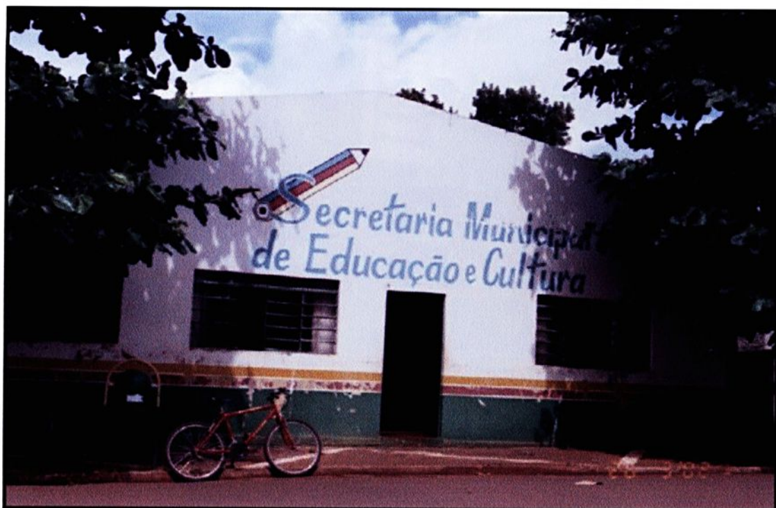
Fig. 3 Vista da Secretaria Municipal de Educação de Sidrolândia/MS.
