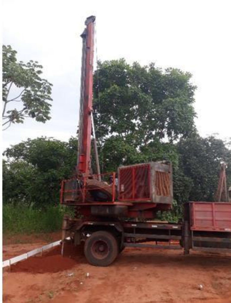
Figura 29 – Processo de execução da fundação profunda.
