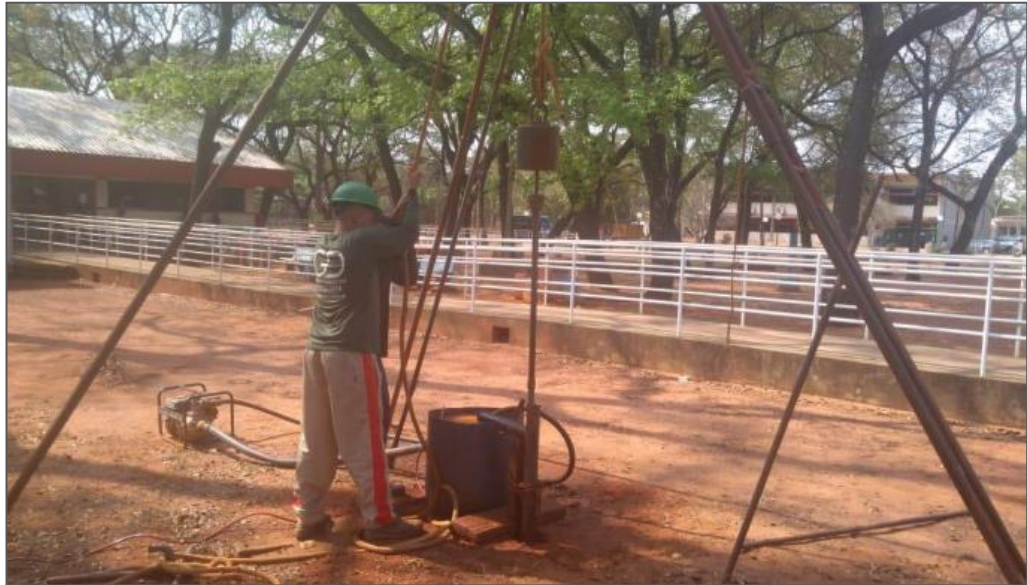
Figura 18 – Ensaio SPT – Parte 02.
