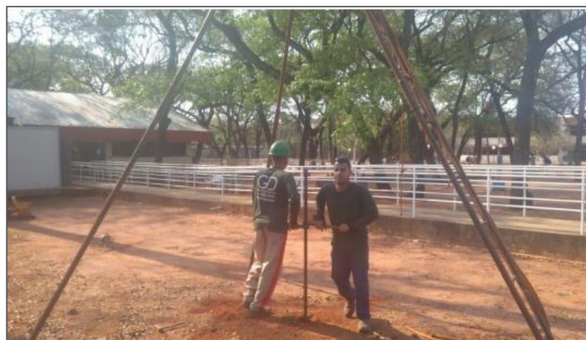
Figura 17 – Ensaio SPT – Parte 01.
