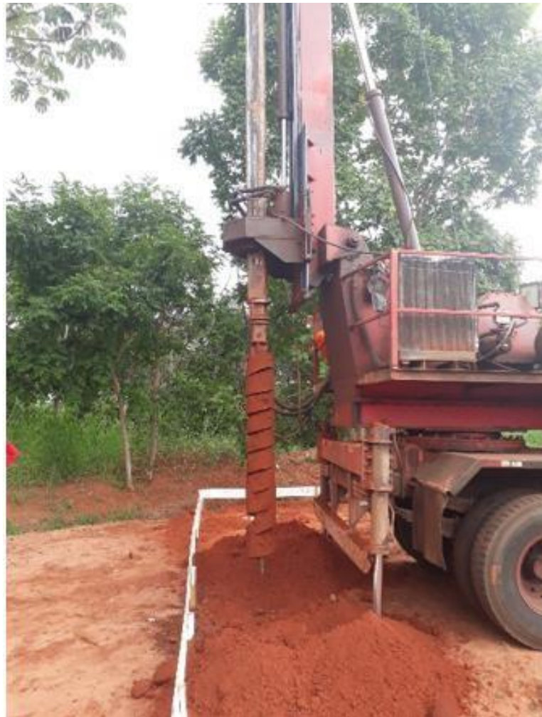
Figura 28 – Início Processo de execução da fundação profunda.
