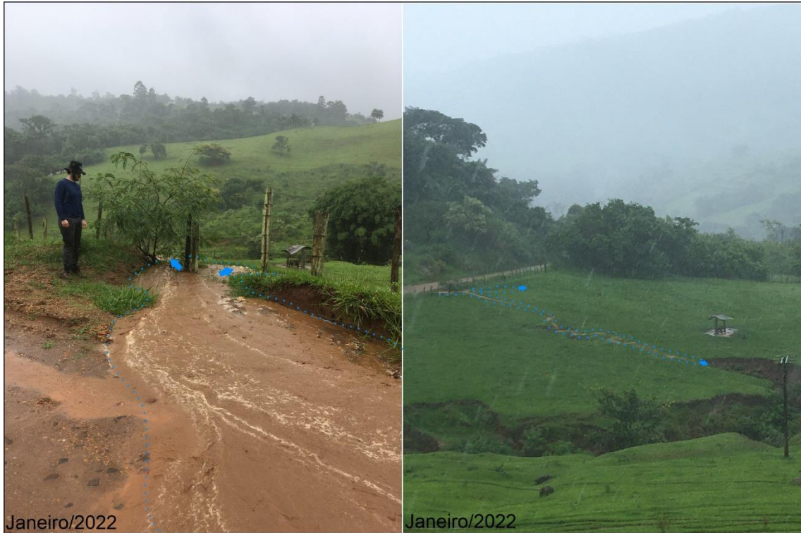
Figura 32 - Vertedouro e fluxo de água superficial.
