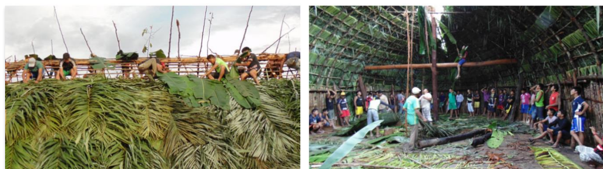
Figura 76 - Etapas finais da cobertura da Takãra . Por Nivaldo Tapirapé (janeiro/2014).
