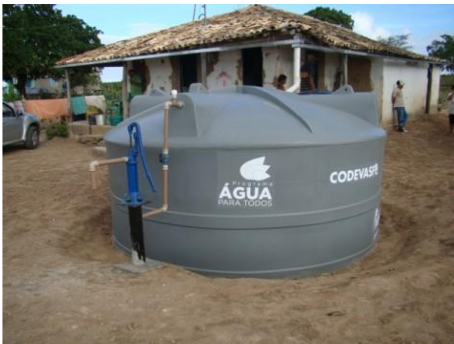
Figura 10: Cisterna instalada pelo programa “Água Para Todos”. Fonte: Cultura Mix
