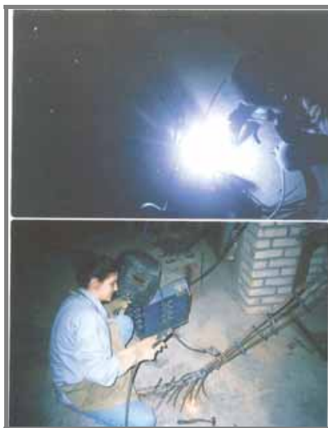
Figura 30: Detalhe da Construção da peça, Florianópolis, 1997
