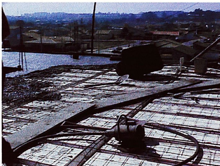
FIGURA 2.12– Laje Pré-fabricada com Tabelas de EPS
