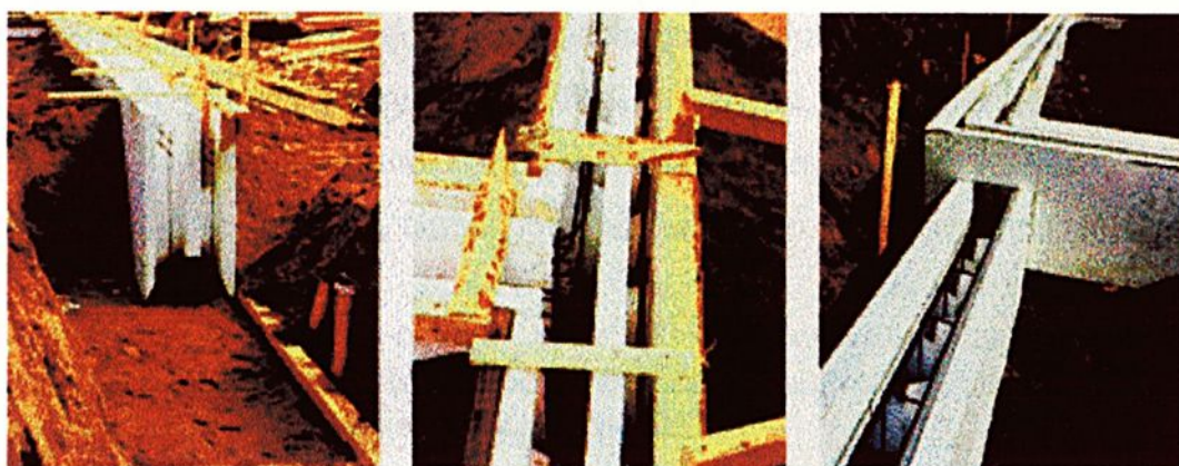
FIGURA 2.18 – Detalhes de uma obra com Styrobloc [BASF, s.d.]
