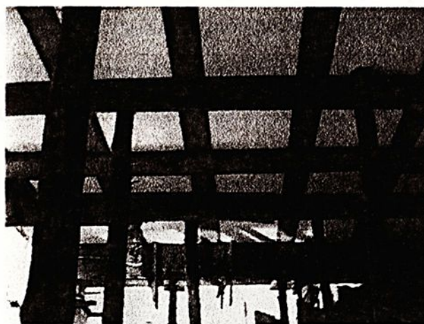
FIGURA 2.9 – Caixão perdido
