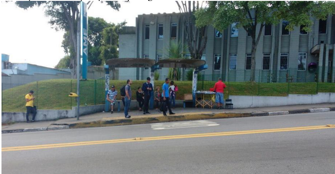
Figura 13: ponto de parada de ônibus com abrigo e marcação no leito carroçável. Falta de identificação e informações para os passageiros - Estrada do São Francisco – Taboão da Serra
