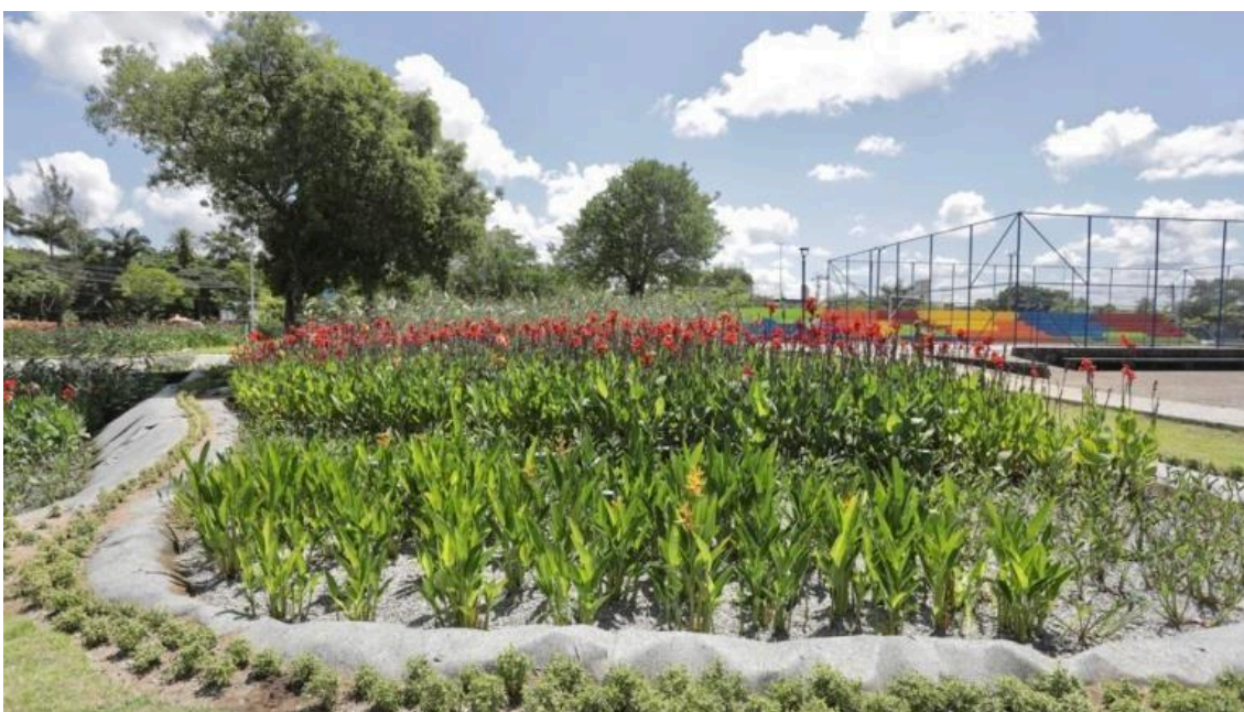
Figura 38. Implementação dos jardins de tratamento em Recife
