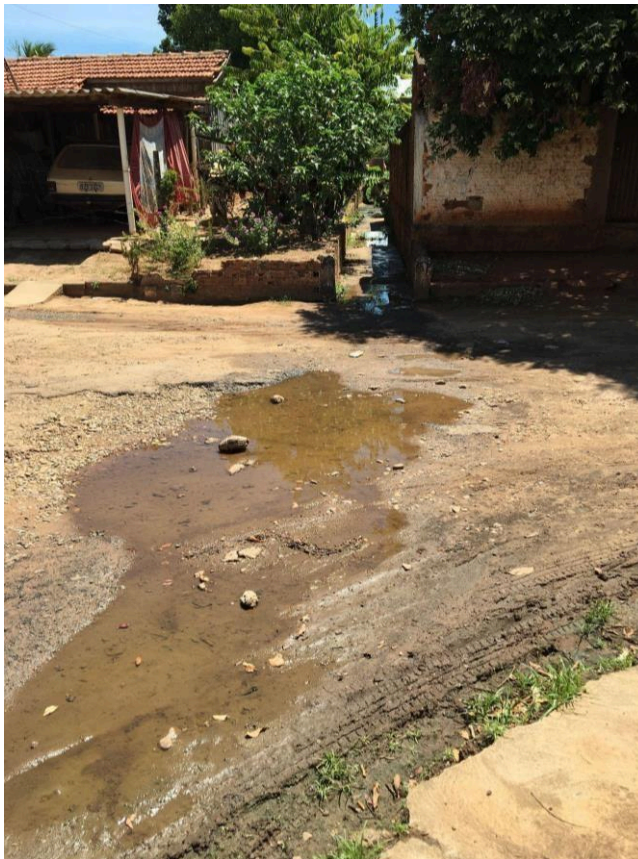
Figura 4. Acúmulo de água nas vias.
