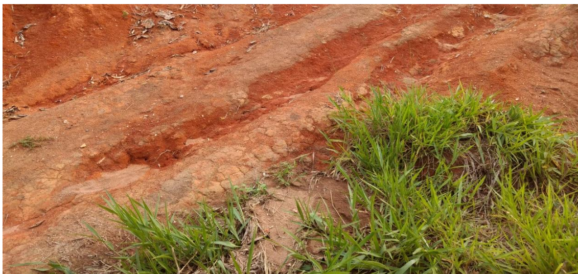
Figura 3 – Área degradada com erosão.
