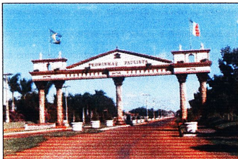
Foto 24: Portal de Entrada. Fonte: Arquivo Público Municipal.
