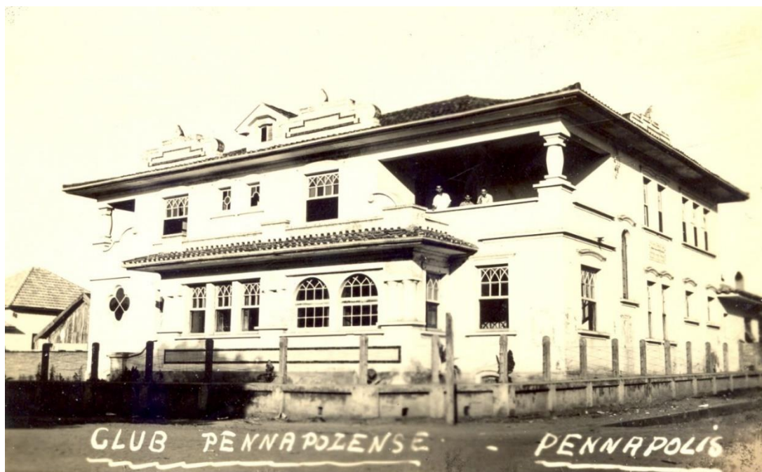
Figura 18: Foto do prédio da 2ª sede do Club Pennapolense, 1925
