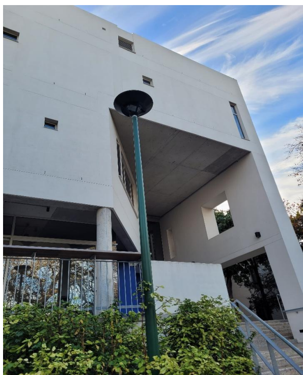
Imagem 6 - A fotografia captura a fachada da School of Education - Neville Alexander Building.
