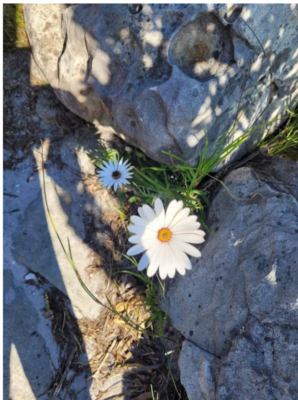
Imagem 4- Das fendas do cimento...
