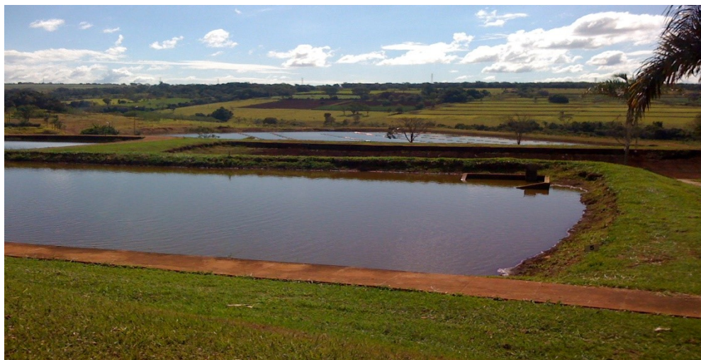
FIGURA 6. Tanques escavados (Fonte: arquivo pessoal).
