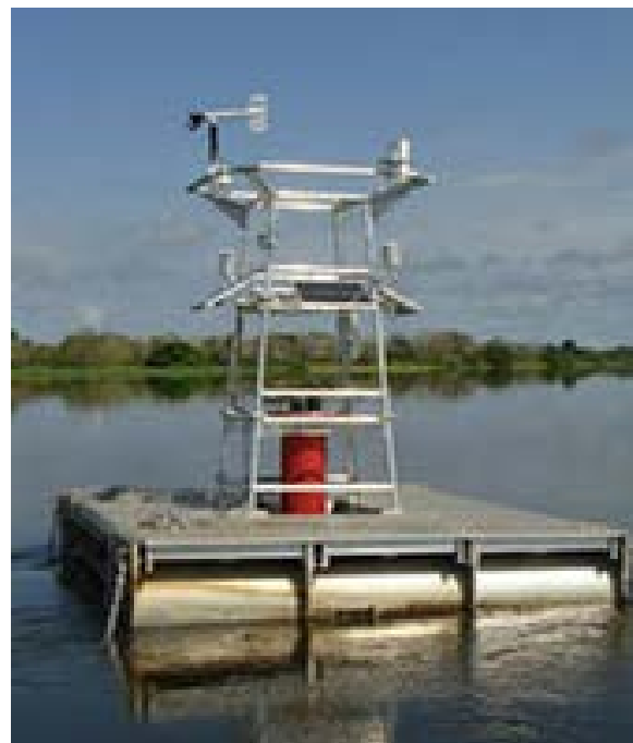
Figura 27 – Estação SIMA composta por uma plataforma flutuante em alumínio naval (INPE, 2014)
