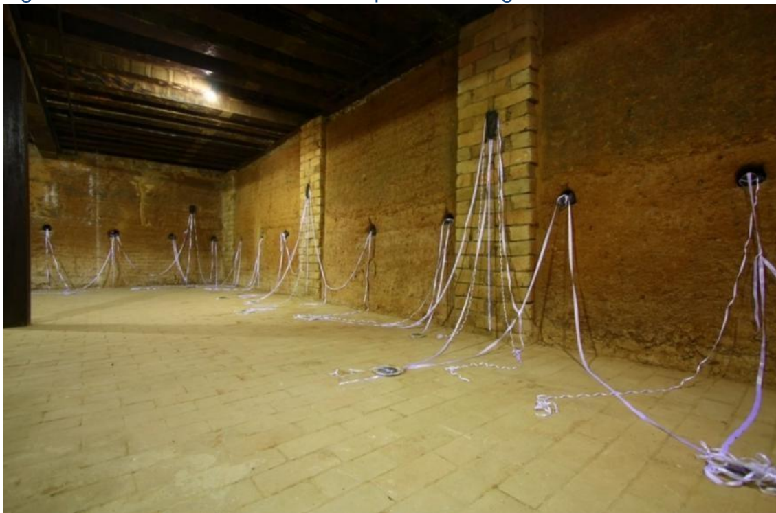
Figura 75- As amas e detalhe de fitas presas e fotografias no chão da senzala
