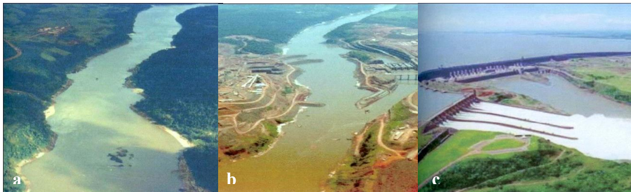
Figura 5 – Imagens da região alagada de Guaíra (PR) durante o processo de construção da represa. a – Leito original do Rio Paraná. b – O Rio Paraná passa a correr pelo canal de desvio. c – Vista aérea atual da UHE Itaipú, na divisa entre Brasil e Paraguai. (Imagens cedidas pela Acessoria de Comunicação de Itaipu Binacional).
