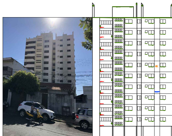
MAPEAMENTO FACHADA SUL
