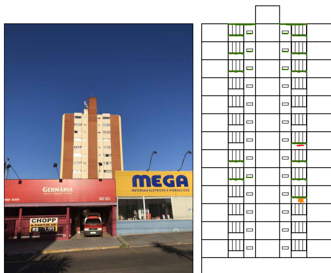
MAPEAMENTO FACHADA LESTE
