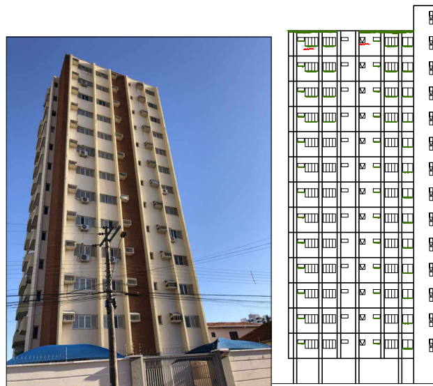
MAPEAMENTO FACHADA SUL
