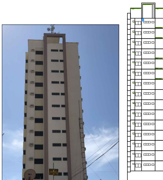
MAPEAMENTO FACHADA SUL
