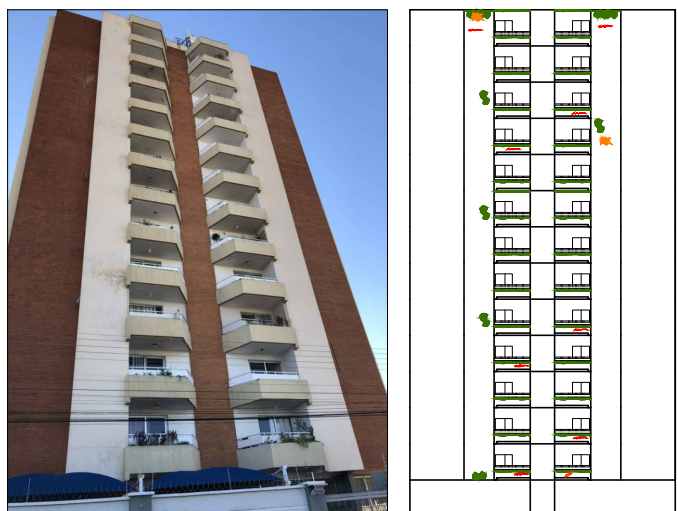
MAPEAMENTO FACHADA OESTE
