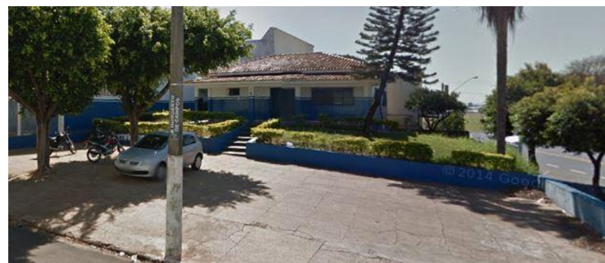
Figura 36: Secretaria de Obras e Assuntos Viários.
