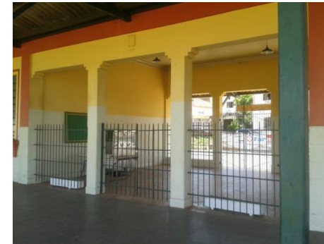
Figura 62: Prédio sede da estação e sanitários.
