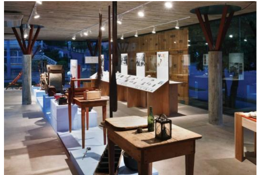
Figura 85: Os capitéis dos pilares e os painéis deslizantes da fachada feitos em madeira.
