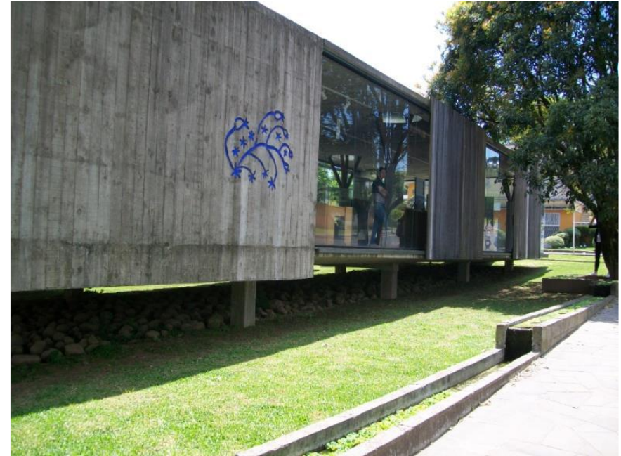
Figura 87: A aparência de madeira no concreto utilizado nos anexos.
