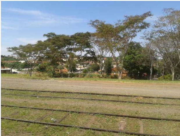
Figura 58: Desnível entre a ferrovia o bairro Sul da mesma.
