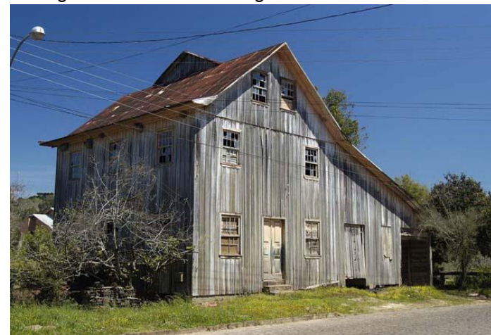
Figura 80: O Moinho Colognese antes do restauro.
