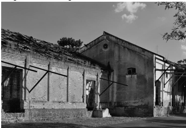
Figura 98: Os antigos armazéns antes do restauro.
