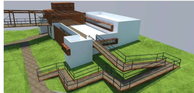
Figura 116: Pavimento superior e brise da fachada Sul.
