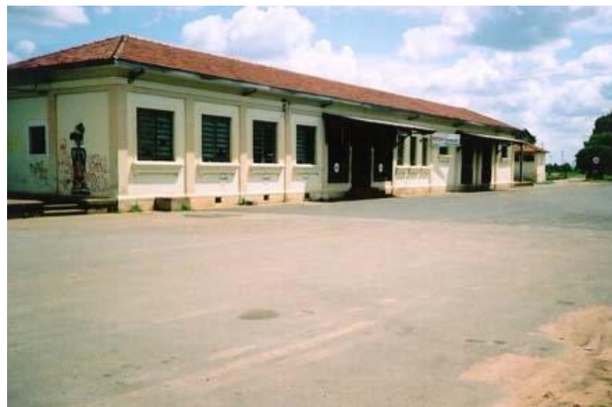
Figura 48: A estação abandonada, degradada e abrigo de mendigos, em 2001.
