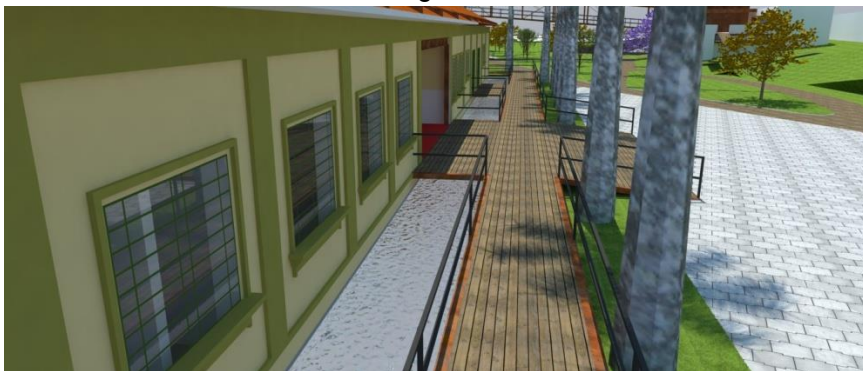
Figura 111: Passarela conectora entre a estação e a praça e tanque d'água.
