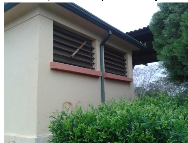
Figura 66: Molduras presentes nas janelas do conjunto de sanitários.
