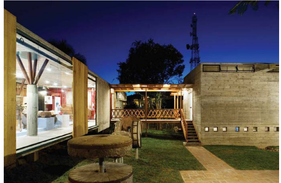
Figura 83: Os dois novos anexos que se interligam através de uma passarela.
