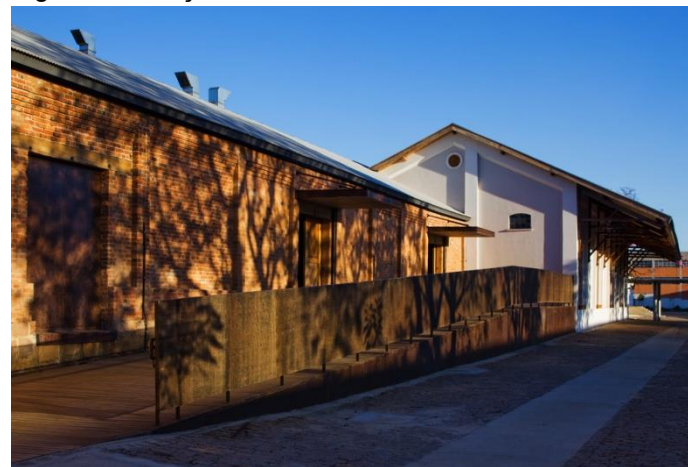
Figura 93: O aço corten demarcando os novos elementos.
