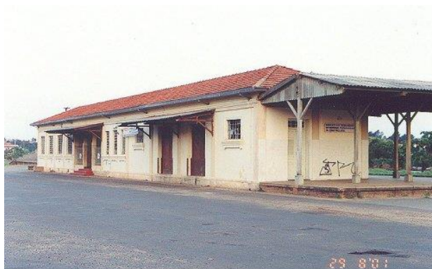
Figura 47: A estação abandonada, degradada e abrigo de mendigos, em 2001.
