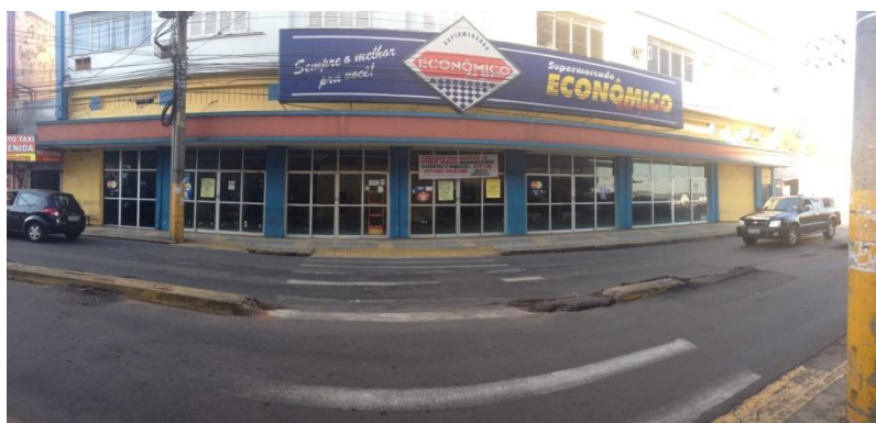
Foto 04 – Fachada do Supermercado Econômico
