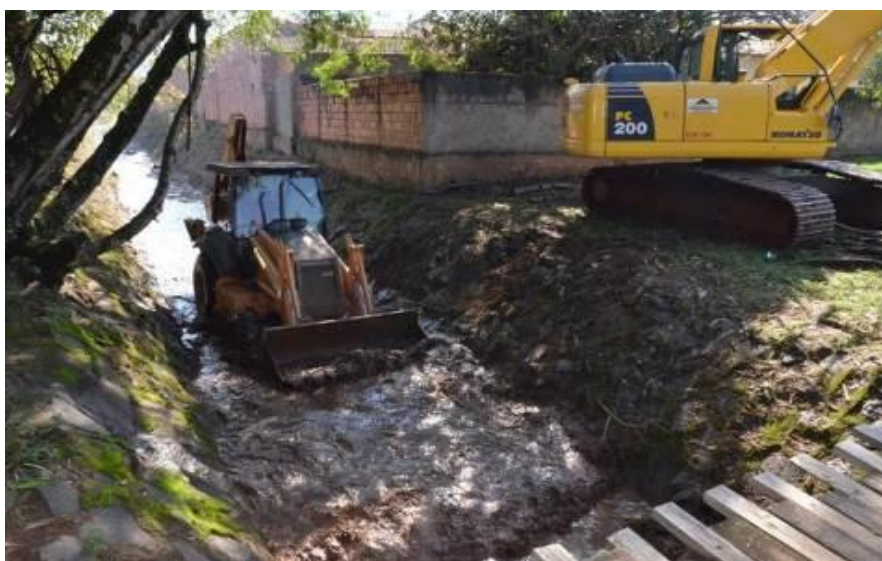
Figura 20 – Serviço de limpeza realizada no Córrego do Jardim São João, setor sul da bacia.
