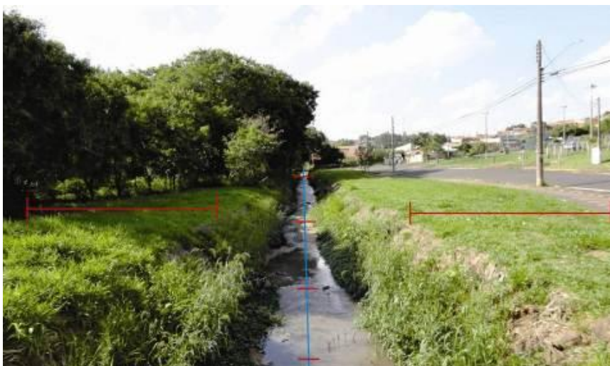
Figura 19 – Trecho do canal retificado próximo à jusante.
