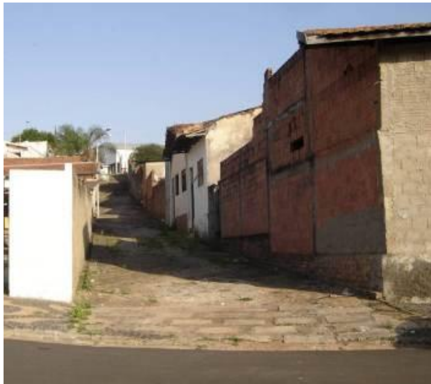
Figura 15 – Trecho da viela do Jardim São João.
