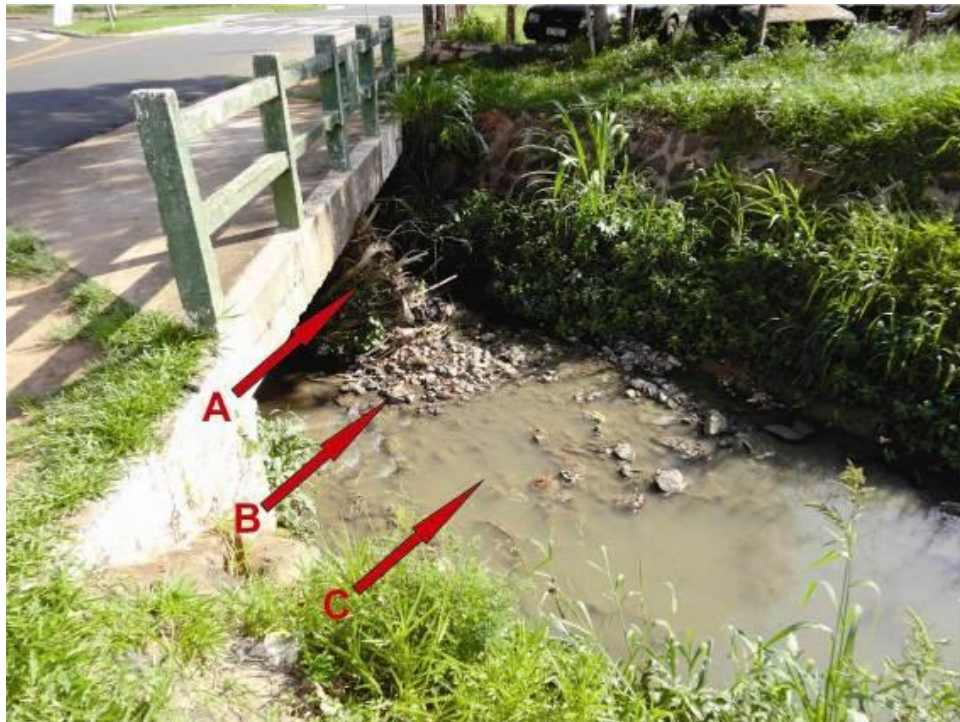
Figura 21 – Trecho próximo à jusante.
