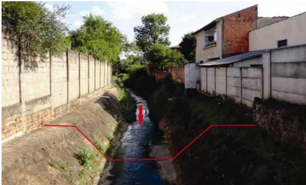
Figura 18 – Trecho do canal retilinizado no setor sul da bacia.
