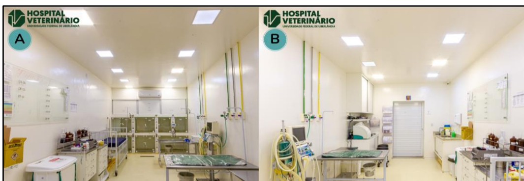
Figura 12: Estrutura da UTI do HOVET-UFU. A: Interior da sala. B: Interior da sala. Fonte: Coordenação do estágio da UFU.
