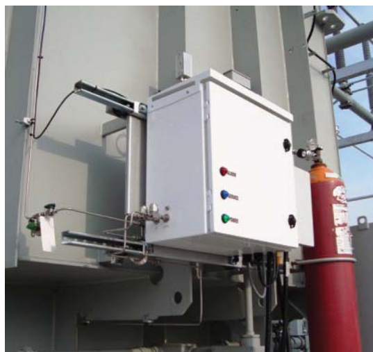
Figura 3.9 – Equipamento de medição de gases instalado em um transformador (SIEMENS, 2012)
