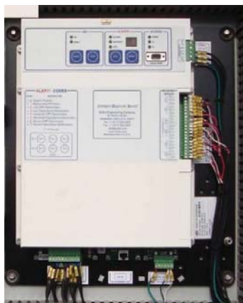
Figura 4.7 – Dispositivo de monitoramento de Buchas
