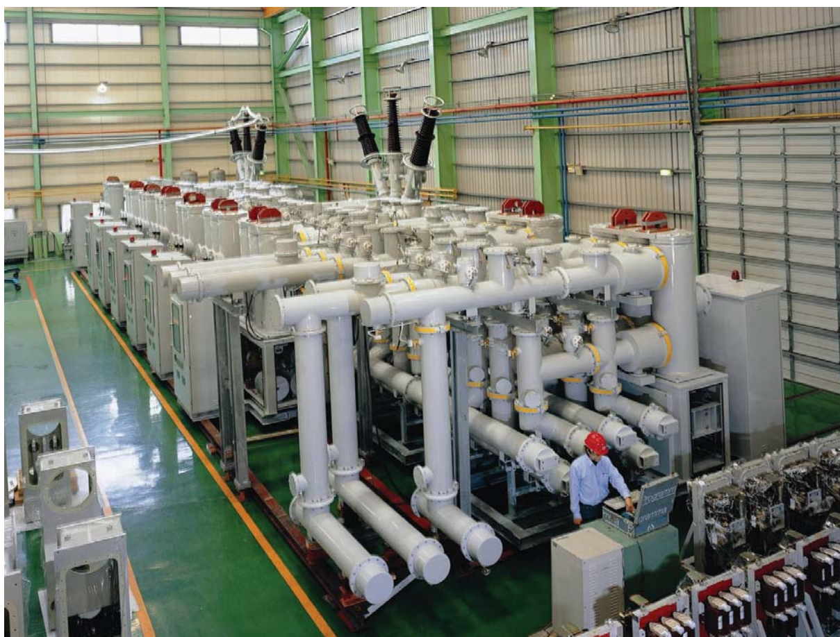
Figura 2.1 – Subestação blindada isolada a gás SF 6 (www.chem.com.tw)
