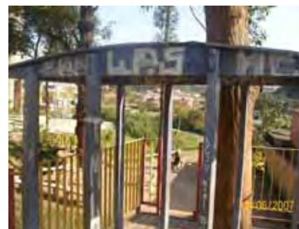
Detalhe do escada – e sua sustentação com a própria madeira da árvore
