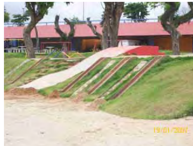
Escorrega de Talude
