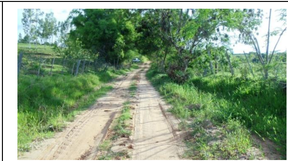
Figura 34: Detalhe do caminho que o escoamento superficial segue no lado direito da estrada.
