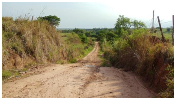
Figura 29: Estrada rural vicinal de terra na área de estudo, margeada por barrancos altos e comprimento de lançante grande.
