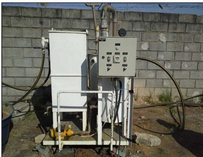
Foto 6- Sistema provisório utilizado no teste de DPE na área 1
