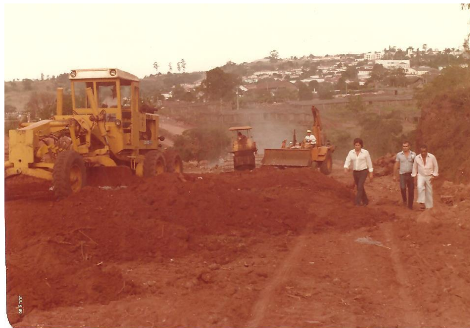
Figura 27 – Área do Parque no início de sua construção – Fase de terraplenagem (1979).
