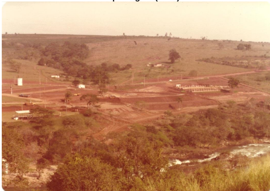
Figura 28 – Área do Parque no início de sua construção – Fase de terraplenagem (1979).
