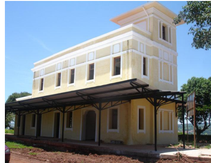
Figura 3 – Estação ferroviária – Projeto de Ramos de Azevedo (1908).
