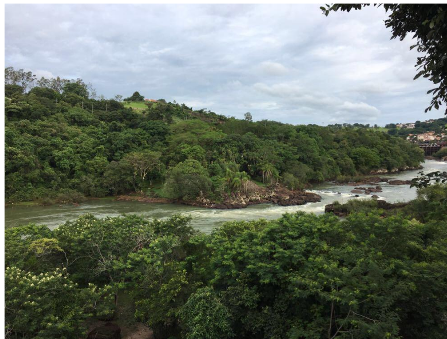
Figura 50 – Vista do mirante para a barragem.
