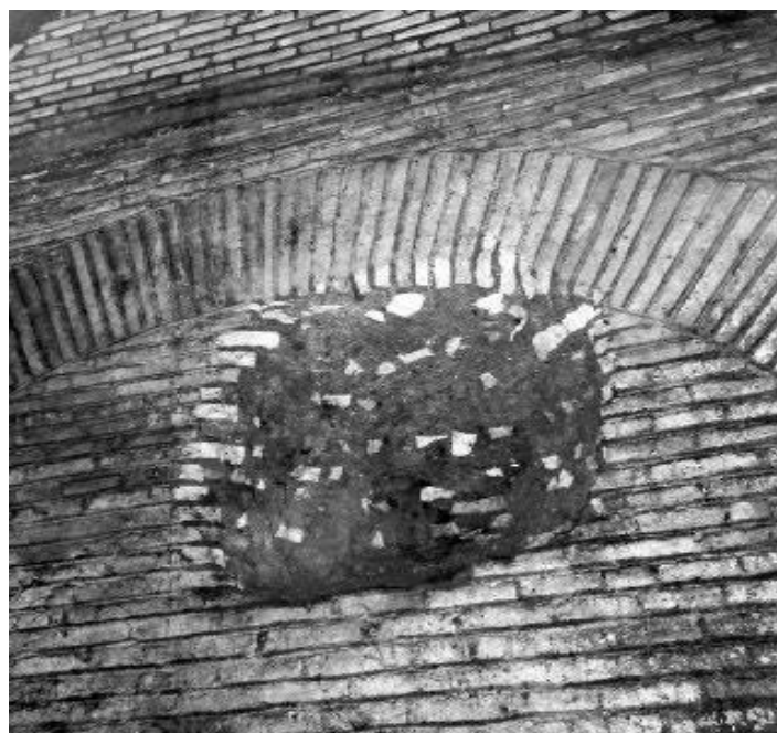
Figura 31 – Ambulacro dei Cavalieri, detalhe do núcleo de concreto da parede de tijolos.
