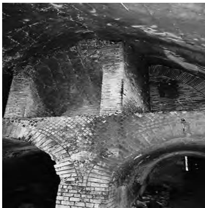
Figura 30 - Teatro de Marcelo: ambiente interno, subestrutura do Ambulacro dei Cavalieri e o vomitorium levando à cavea
