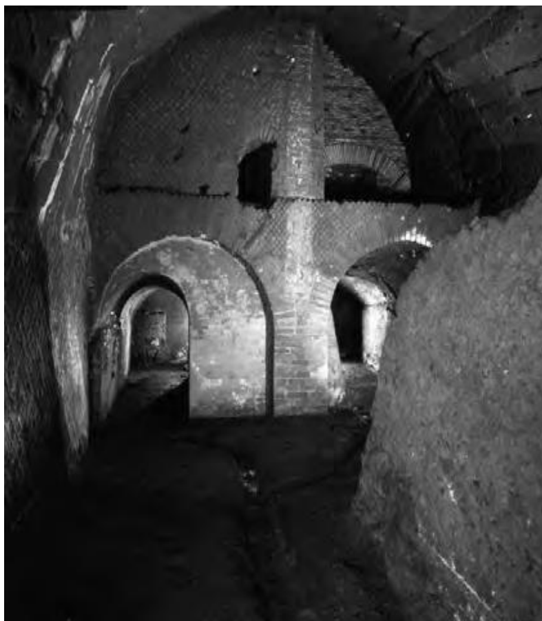
Figura 26 — Cunei interno: construção do Ambulacro dei Cavalieri . Visíveis a alvenaria e a parede de tijolos do ambulacro
