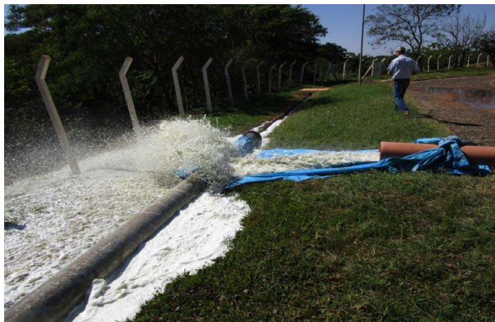
Figura 4-32. Remoção do produto químico por bombeamento
