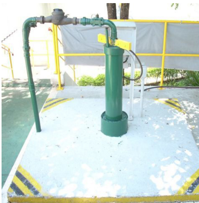
Figura 4-25. Exemplo de laje de proteção em poços
