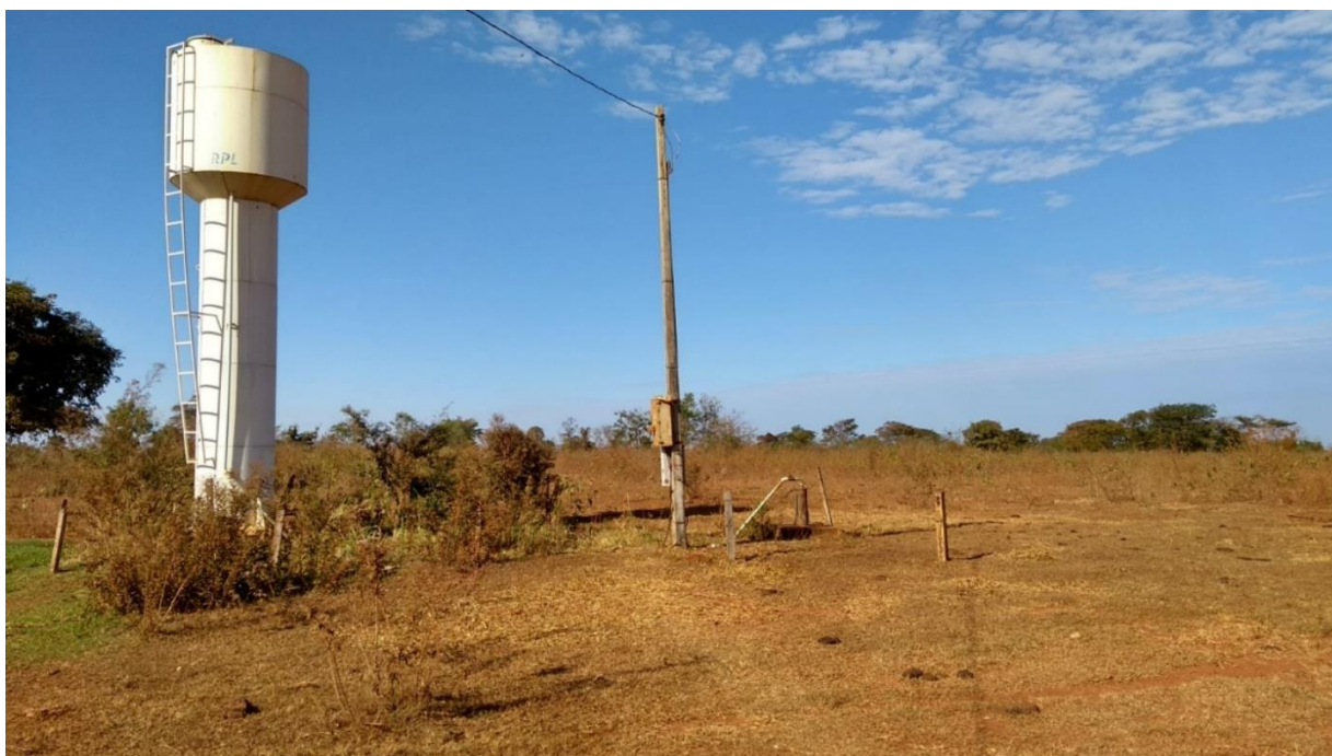
Figura 36 – Poço tubular e reservatório comunitário no assentamento Estrela da Ilha no município de Ilha Solteira
