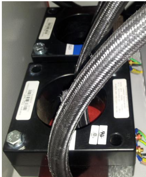
Figura 4.13 – Transformador de Corrente.
