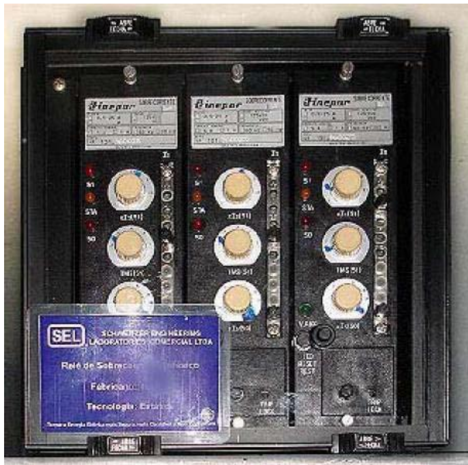
Figura 3.13 – Relé eletrônico ou estático.
