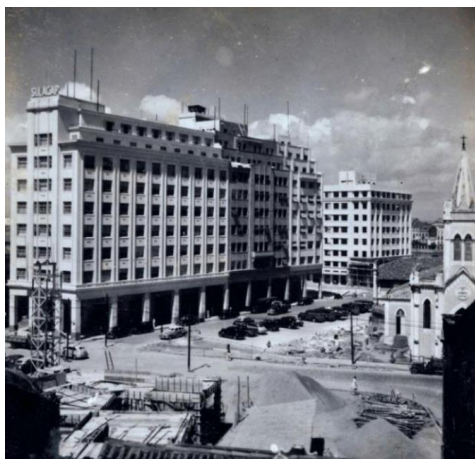
Figura 22: Construção de prédios na Avenida Dez de Novembro, 1944
