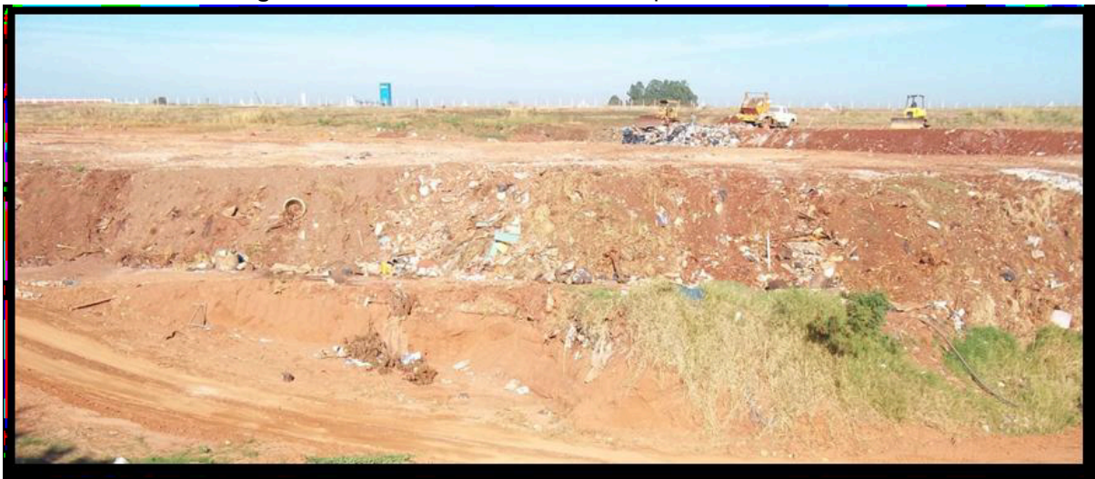
Figura 4 - Aterro Controlado do município de Ourinhos-SP
