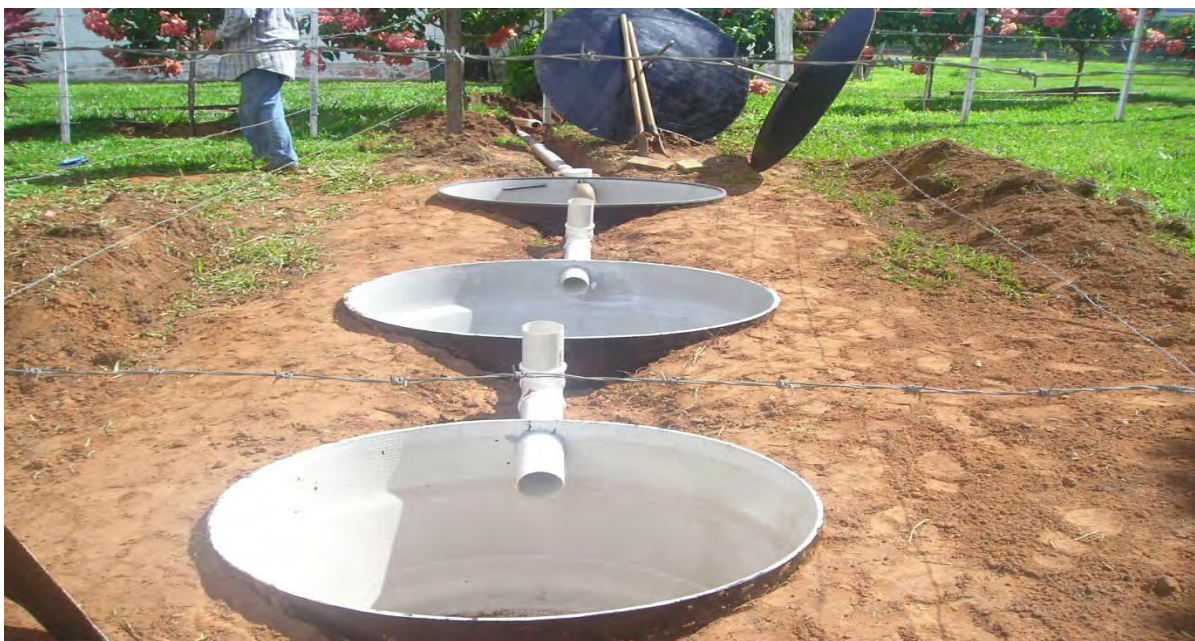
Figura 28 – Foto da instalação de fossa séptica biodigestora pelo programa de microbacias em uma propriedade rural no Córrego do Ribeirão Lagoa, município de Jales. Fonte: Casa da Agricultura de Jales.
