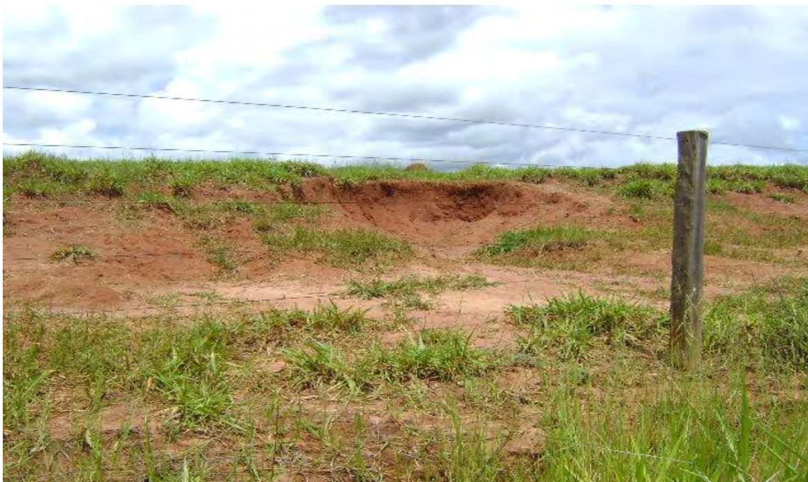
Figura 21 – Pastagem degradada na microbacia do córrego do Cervo, município de Urânia, onde é possível observar o início de processos erosivos, como resultado do manejo inadequado do solo, caracterizando um “descaso” do proprietário para com esta área, justamente numa microbacia abrangida pelo programa de microbacias. Autor: Evandro César Clemente. Fonte: Trabalho de campo, janeiro de 2009.
