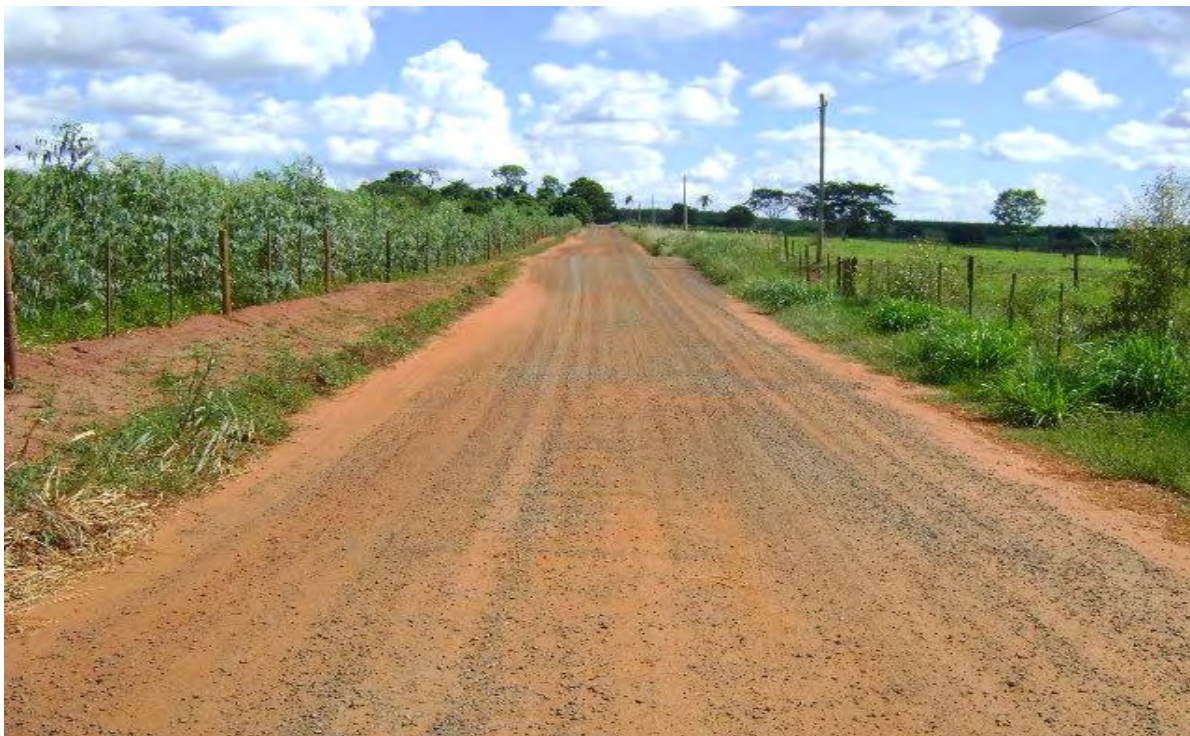
Figura 32 – Readequação de estrada na microbacia do Sucuri, realizada pelo programa de microbacias no município de Palmeira d'Oeste. Foto: Evandro César Clemente. Fonte: Trabalho de campo, janeiro de 2009.
