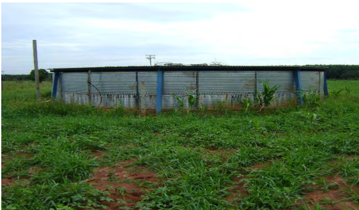
Figura 19 – Abastecedouro comunitário com capacidade de 208.000 litros, construído no Córrego do Cavalo, pelo programa de microbacias, no município de Santa Albertina. Fonte: Trabalho de campo, dez/2008. Autor: Evandro César Clemente.
