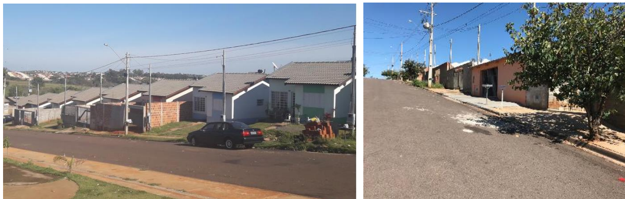
Figura 79 – Ausência de acessibilidade nos passeios públicos do CHJDN
