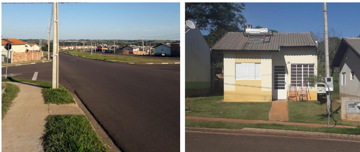
Figura 67 – Calçadas do CHJDN com faixas livre e de serviço permeáveis
