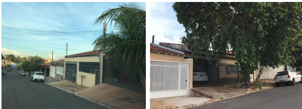
Figura 33 – Ausência de acessibilidade nos passeio públicos do CHAJ
