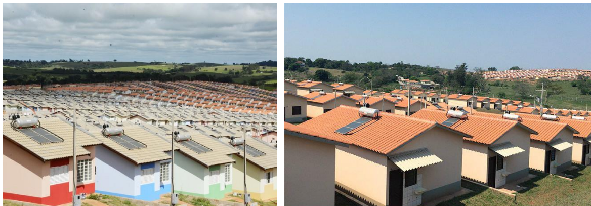
Figura 100 – Sistema de aquecimento solar em residências do CHJDN
