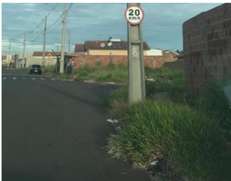
Figura 78 – Calçada no CHJDN com faixas permeáveis com vegetação sem manutenção
