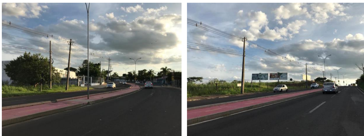
Figura 34 – Ciclovia inserida na Rodovia Alberto Bonfiglioli nas proximidades do CHAJ
