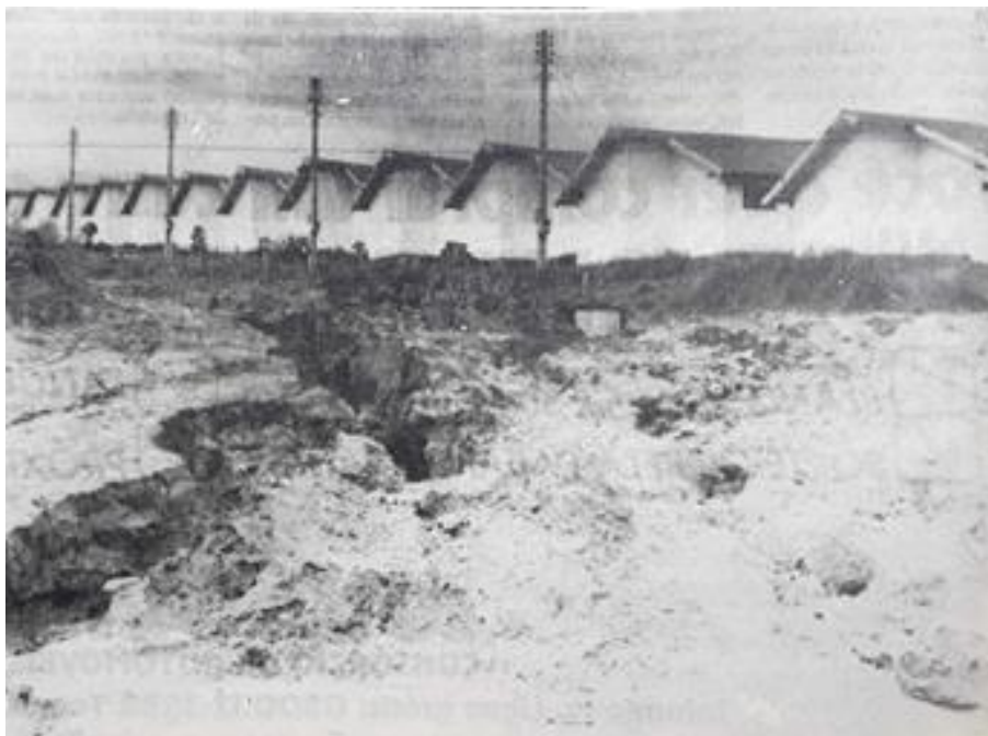
Figura 19 - Erosão em via pública no conjunto Habitacional Ana Jacinta, próxima às residências.
