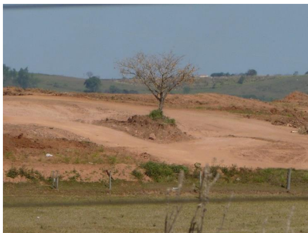
Figura 56 – Árvore ilhada devido à retirada de terra para a construção do CHJDN
