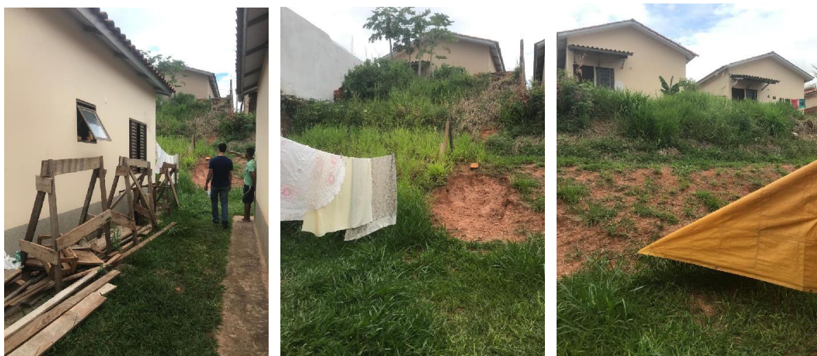
Figura 59 – Talude entre residências do CHJDN
