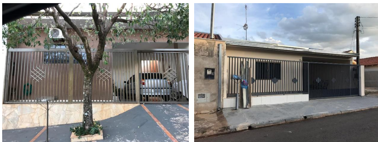
Figura 40 – Recuo frontal diminuto em residências do CHAJ
