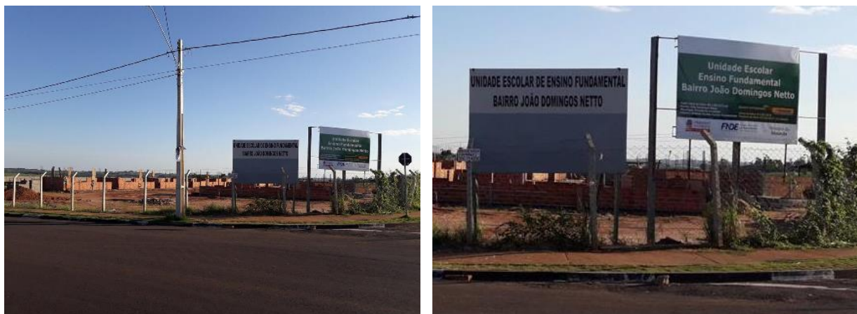
Figura 74 – Edifício de uma unidade de Ensino Fundamental no CHJDN em construção
