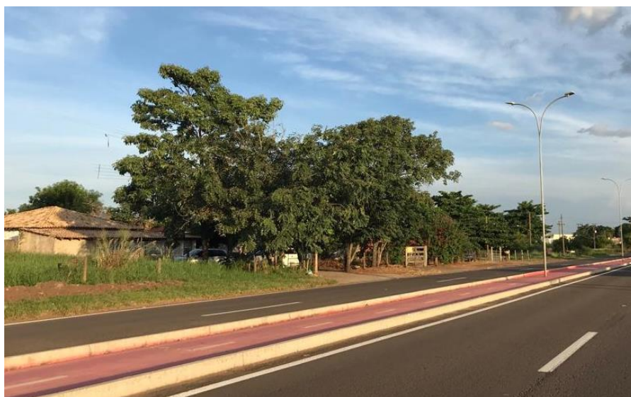
Figura 32 - Rodovia Alberto Bonfiglioli, com destaque ao passeio público sem pavimentação e ausência de acostamento
