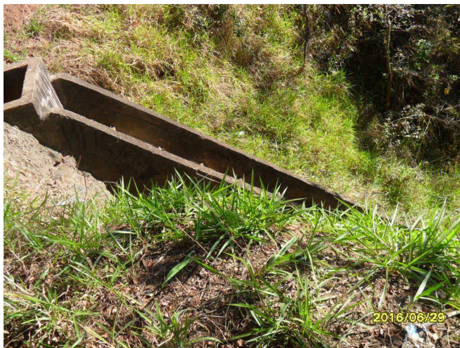
Foto 6 – Obra criada para contenção do escoamento superficial. Fonte: Arquivo do autor.
