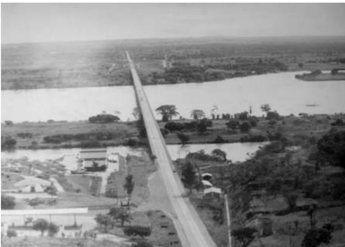
Foto 2. Foto aérea da Ponte Maurício Joppert sobre o Rio Paraná, antes da cheia do Reservatório da Usina Sérgio Motta. Primeiro plano Presidente Epitácio (Margem Esquerda), ao fundo Porto XV de Novembro (Margem Direita). FONTE: Secretaria de Educação e Cultura de Bataguassu.
