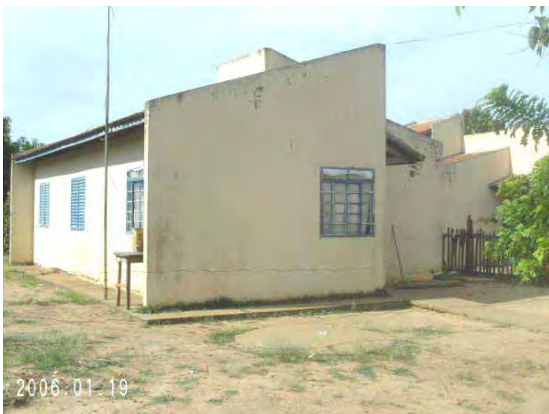
Foto 28. Casa de Nova Porto XV com estrutura original, 2006. FONTE: Autora.
