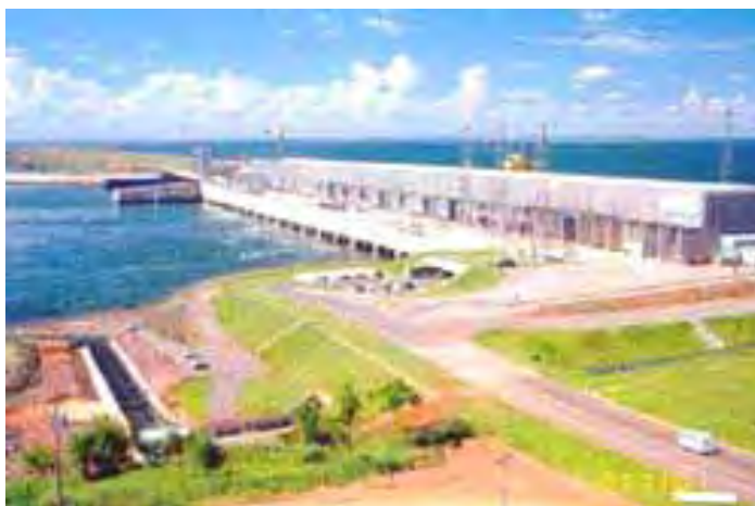
Foto 22. Usina Hidrelétrica Engenheiro Sergio Motta de Porto Primavera. FONTE: CESP.
