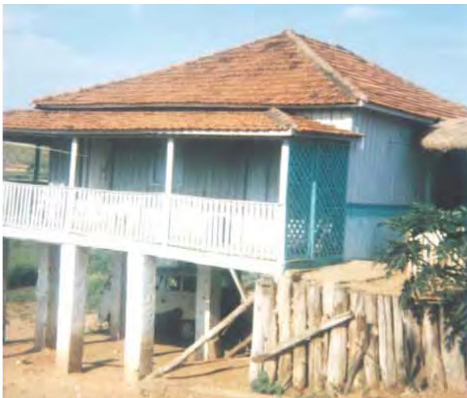
Foto 9. Casa de pescador sobre estacas na barranca do Rio Paraná, 1989. FONTE: Teresa do Catau.
