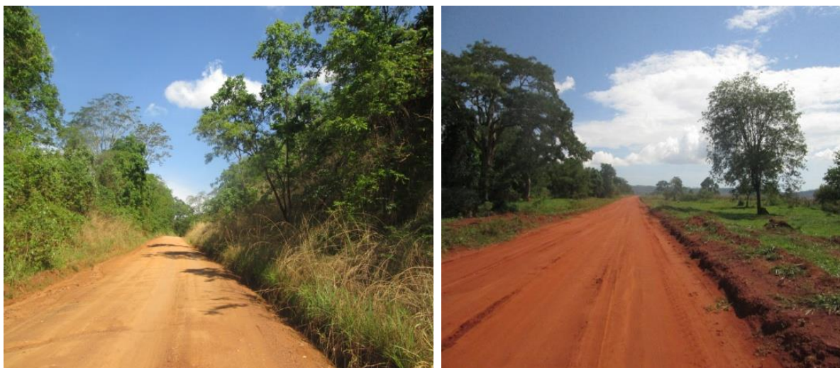
Figuras 15 / 16. Rodovia MG 734
