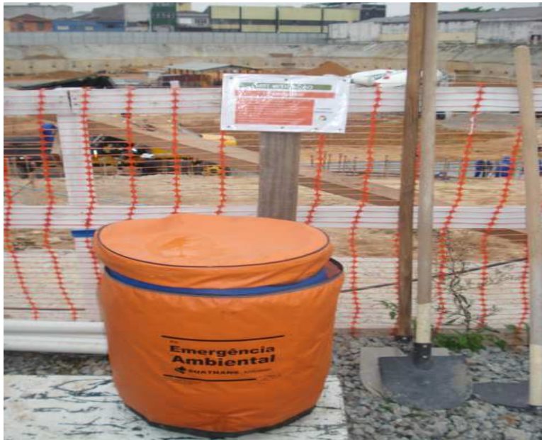
Figura 52 – “Kit” mitigação localizado nas frentes de serviço da construção.
