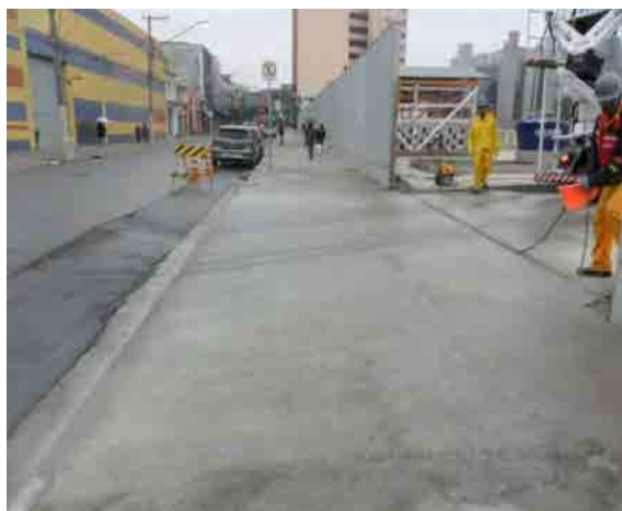
Figura 38 – Portão de acesso de veículos da obra.
