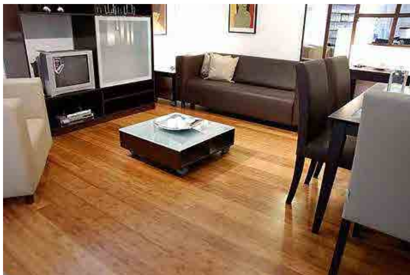
Figura 20 – Uso do piso de bambu na construção de uma edificação localizada em São Paulo – SP, Brasil.
