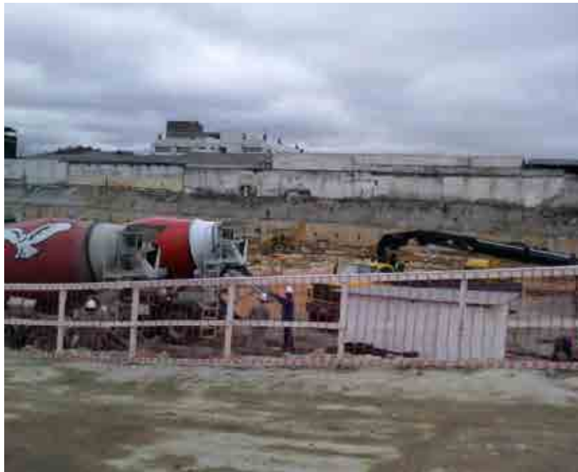
Figura 46 – Controle tecnológico da obra fazendo a retirada do material do caminhão betoneira para posterior produção do corpo de prova.
