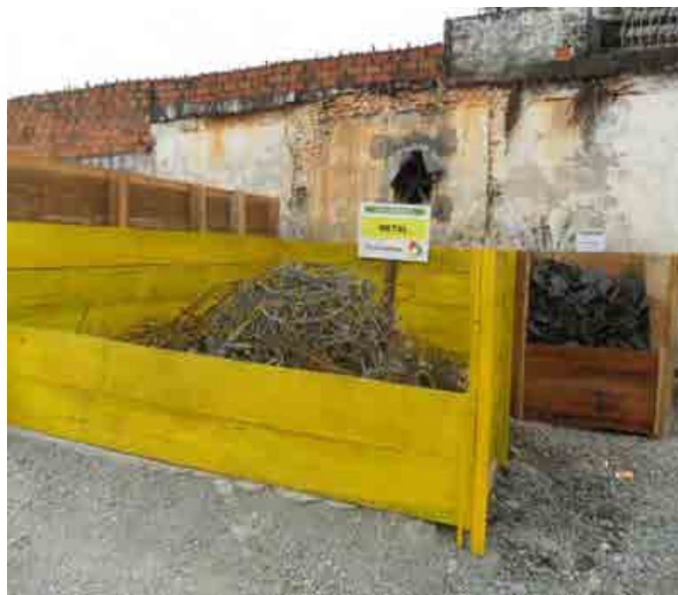
Figura 61 – Baias para segregação dos resíduos de metais.
