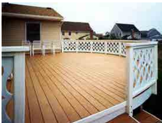
Figura 21 – Uso da madeira plástica na construção de um deck em uma edificação.
