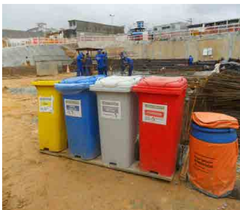
Figura 54 – Coletores localizados na frente de serviço da construção.
