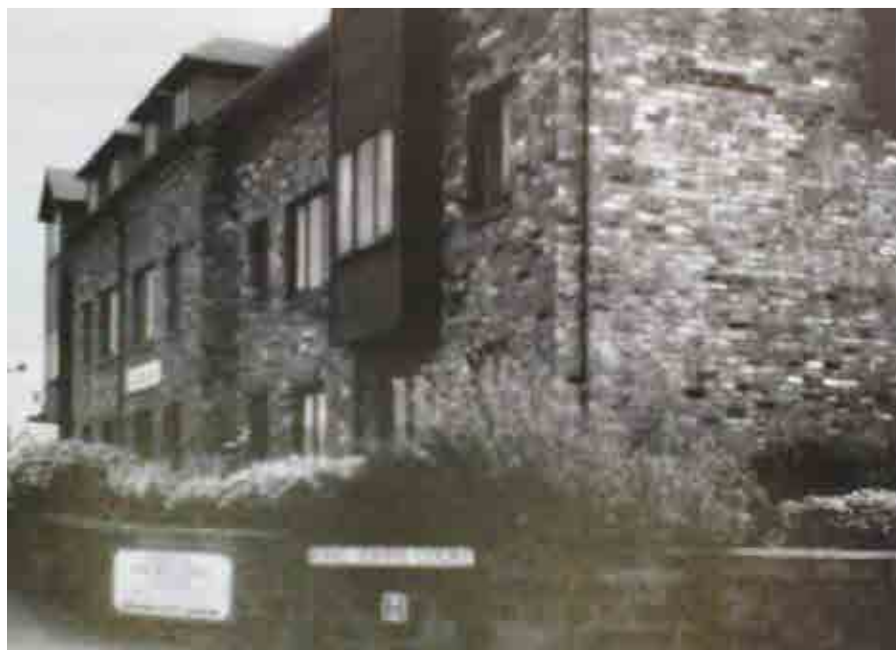
Figura 24 – Construção localizada em Tewkesbury, Reino Unido, onde foram empregados tijolos reaproveitados.
