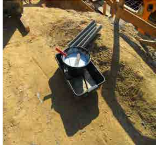
Figura 44 – Utilização de bacias de contenção para evitar a contaminação do solo com a tinta.
