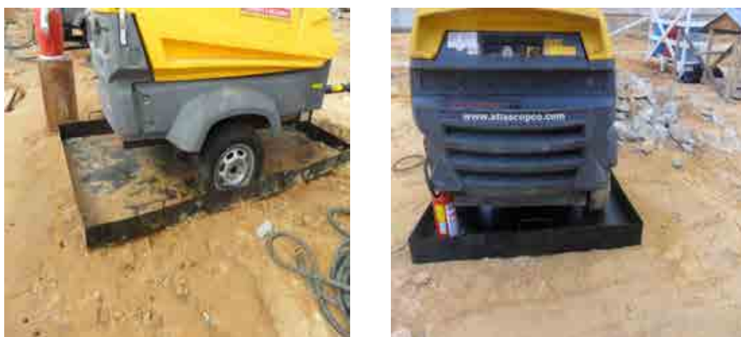
Figura 49 – Utilização de bacias de contenção na parte inferior do maquinário da obra.
