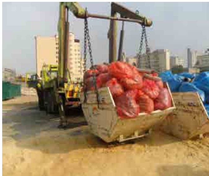
Figura 58 – Transporte dos resíduos de plástico (sacos vermelhos) e papel/papelão (sacos azuis) oriundos da execução do empreendimento.
