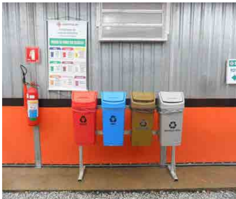
Figura 53 – Coletores de resíduos localizados na frente do canteiro de obras.
