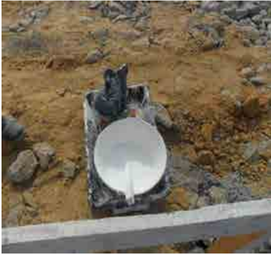
Figura 44 – Utilização de bacias de contenção para evitar a contaminação do solo com a tinta.
