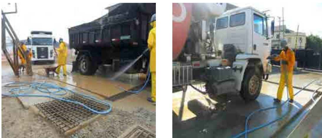
Figura 39 – Execução da lavagem das rodas do caminhão betoneira na saída do mesmo da obra.
