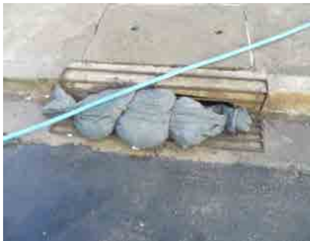
Figura 37 – Proteção para as bocas de lobo do entorno da obra.
