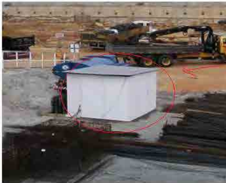
Figura 47 – Local de produção e armazenamento dos corpos de prova de concreto.
