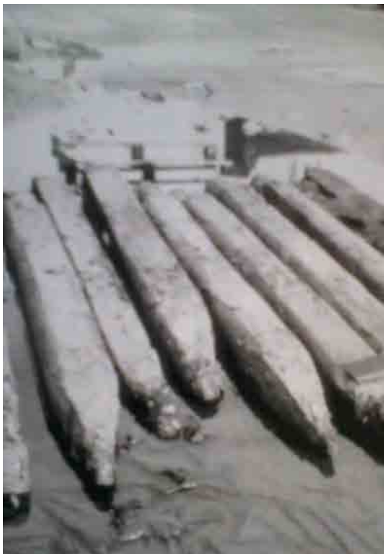
Figura 25 – Estacas de madeiras inspecionadas e consideradas em ótimas condições para o reuso.
